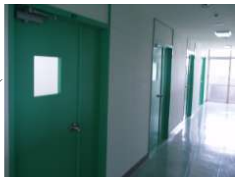
個室を8室に増設した4西病棟
